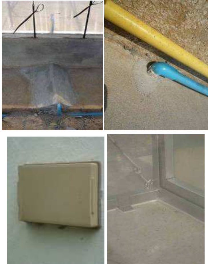
รูปที่ 3 การอุดช่องเปิดที่เกิดขึ้นจากการเจาะท่อต่างๆ และการยาแนว
