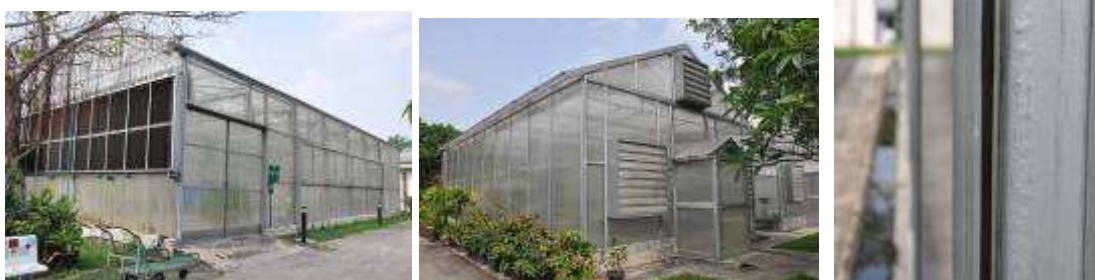
รูปที่ 8 โรงเรือนพลาสติกแข็งฐานคอนกรีต และการติดแถบยางระหว่างพลาสติกกับโครงสร้าง เพื่ออุดช่องว่าง
