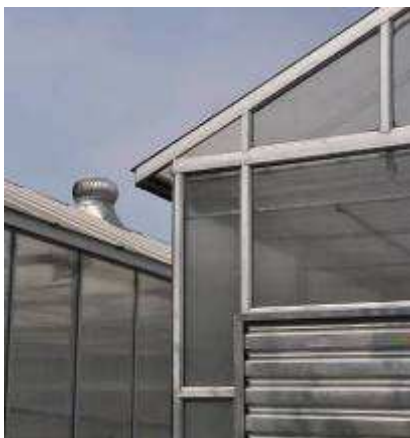
รูปที่ 25 ช่องเปิดและพัดลมระบายอากาศ
