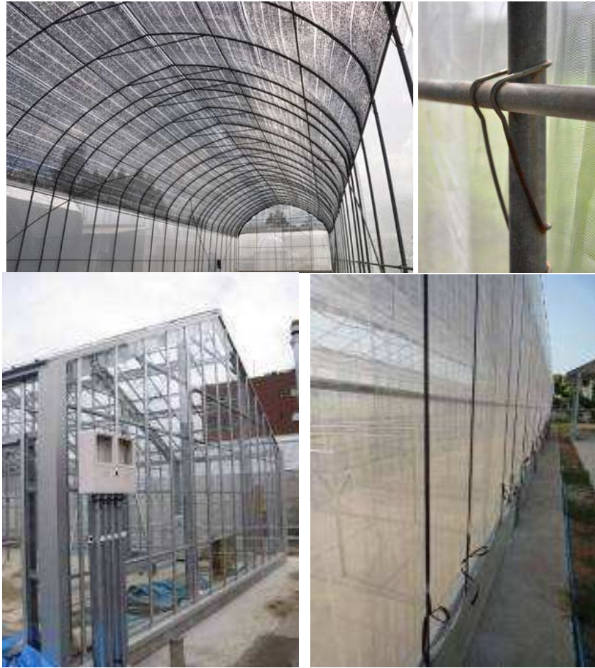
รูปที่ 6 โครงสร้างโรงเรือนจากเหล็ก อะลูมิเนียม และการยึดโรงเรือนตาข่ายด้วยสลิง
