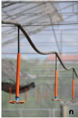
รูปที่ 27 ระบบฉีดพ่นน้ำ (ก) และแผงไอน้ำที่ใช้ร่วมกับพัดลมระบายอากาศ (ข)
