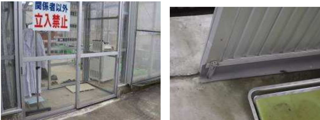
รูปที่ 14 ประเก็นที่ขอบประตูป้องกันสัตว์ขนาดเล็กและแมลง
